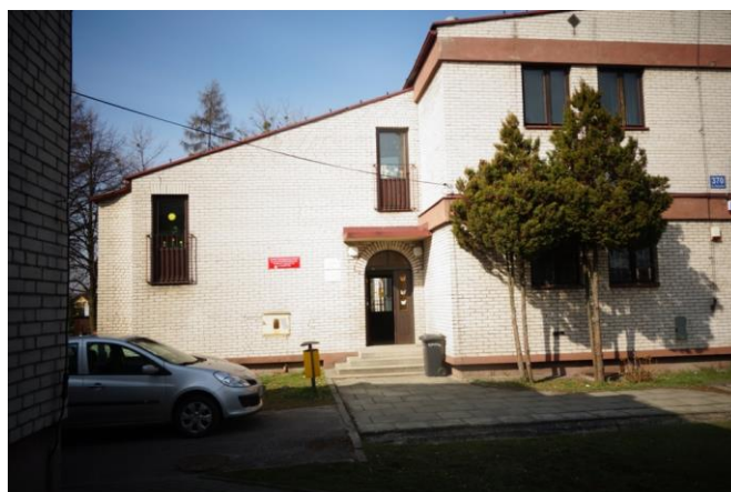
Budowa Gminnej Świetlicy Środowiskowej w Gostyni
