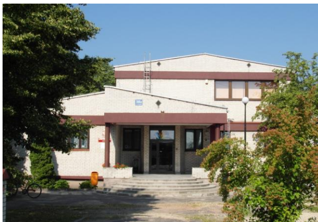
Budynek Gminnego Przedszkola w Gostyni
