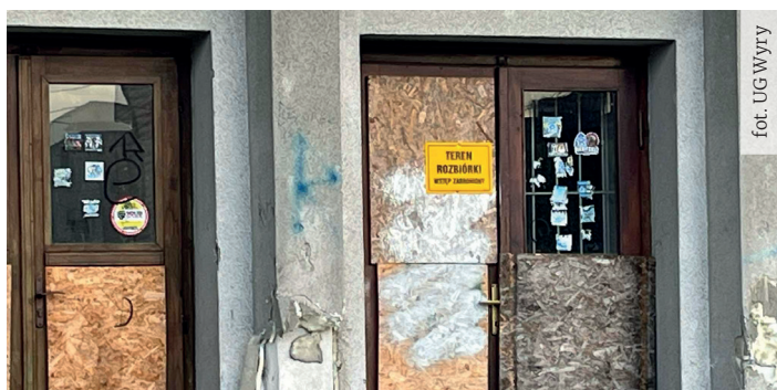
Rozbiórka budynku byłego domu kultury ruszyła w połowie maja
