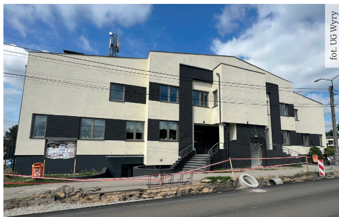
Budynek biblioteki w Gostyni przeszedł termomodernizację
