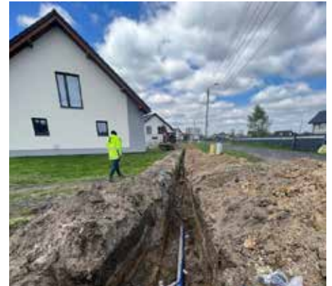
W latach 2018-2024 w Gostyni wybudowano ponad 16 km sieci kanalizacyjnej
