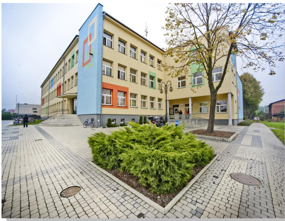
Budynek Szkoły Podstawowej
