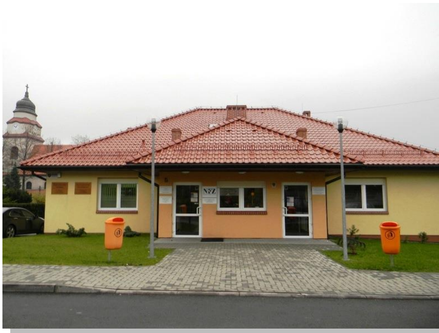
Budynek ośrodka zdrowia
