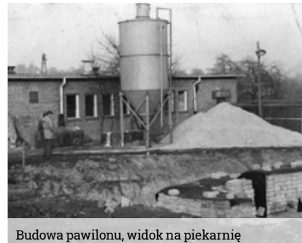
Budowa pawilonu, widok na piekarnię
