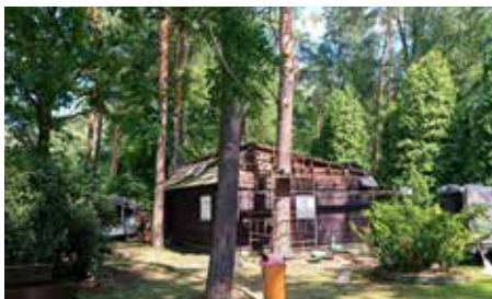
Wymianę pokrycia dachu wykonała firma Bratex
