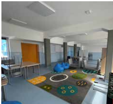
Świetlica szkolna została znacznie rozbudowana
