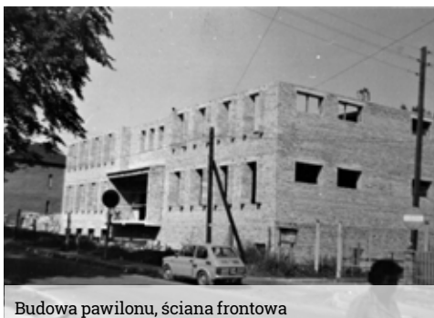
Budowa pawilonu, ściana frontowa
