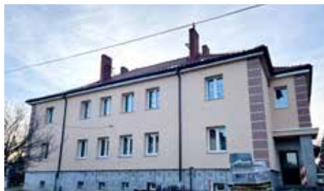
W jednym z budynków przy ul. Bojdoła zakończono już prace termomodernizacyjne
