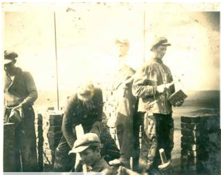
Budowa nowego kościoła
