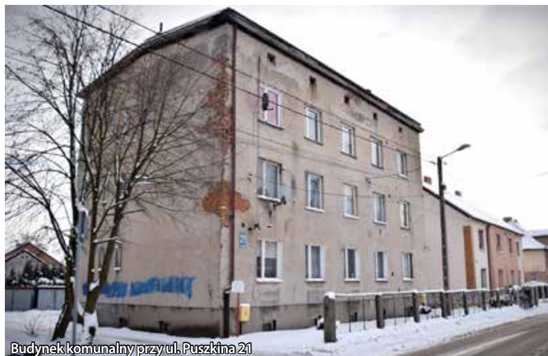
Budynek komunalny przy ul. Puszkina 21
