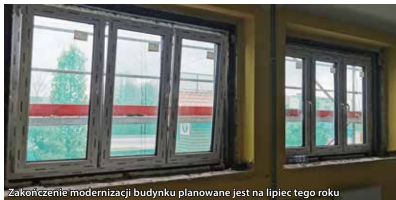
W domu kultury wymieniono już okna, a wkrótce budynek zostanie ocieplony i zyska nową elewację
