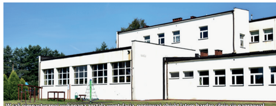
W sali gimnastycznej wykonano wentylację, ponieważ obiekt latem bardzo silnie się nagrzewał
