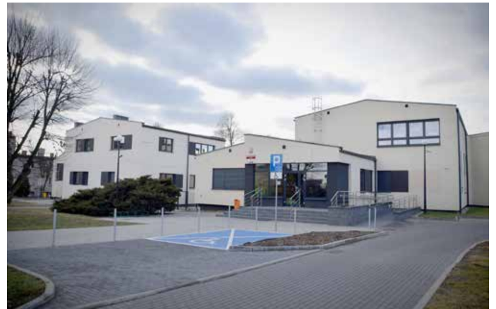
Zmodernizowany budynek świetlicy kolorystycznie komponuje się z gostyńskim przedszkolem
