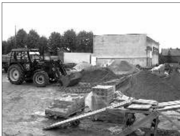
Budowa łącznika pomiędzy salą gimnastyczną, a szkołą.
