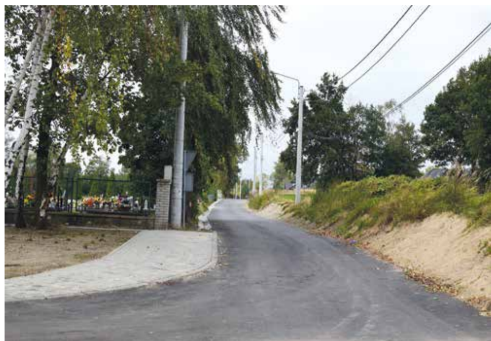
Na ul. Słonecznej wykonana została nowa nawierzchnia oraz kanalizacja deszczowa
