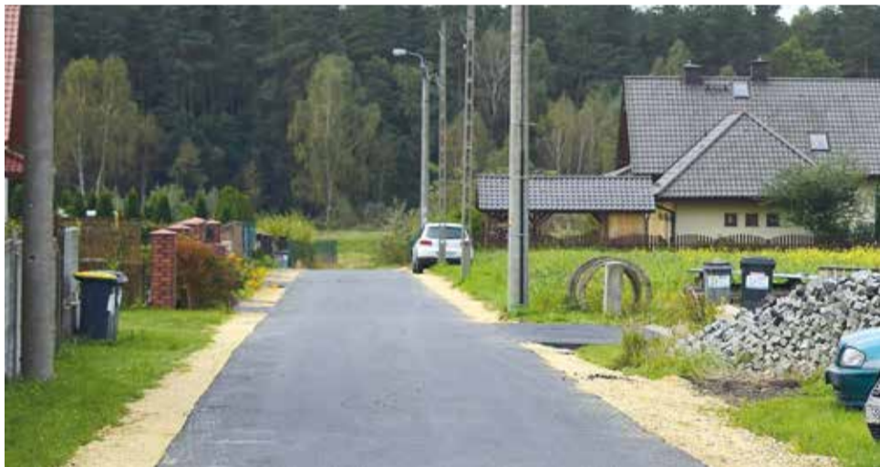
Nowy asfalt pojawił się na trzech odnogach ul. Rybnickiej...
