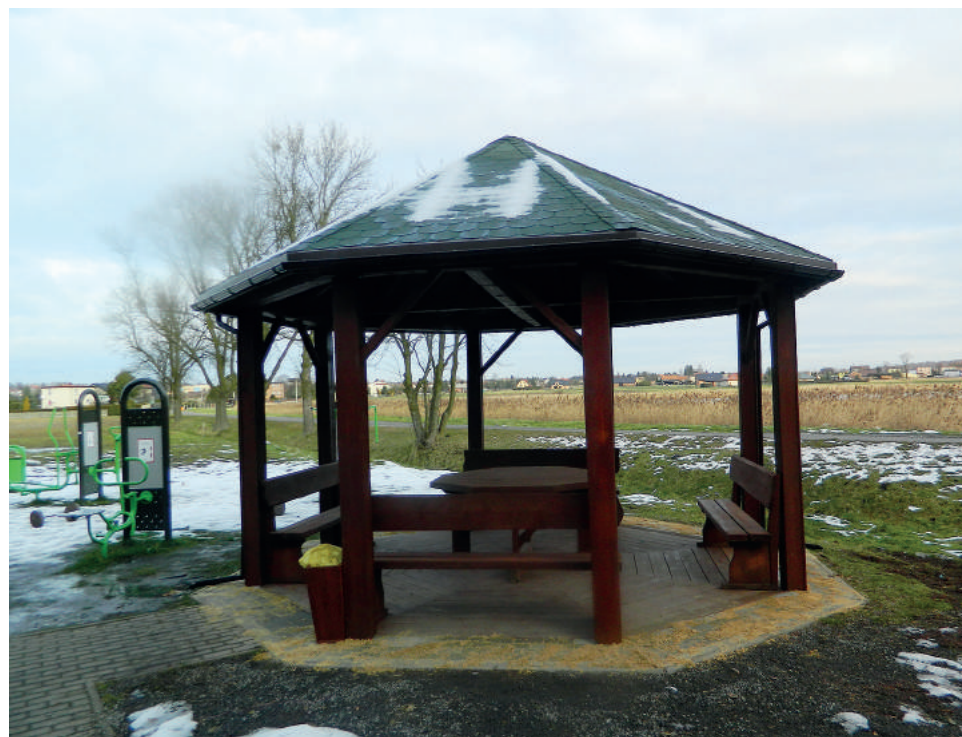
Wiatka „przy Wiciu” na ul. Wagonowej
