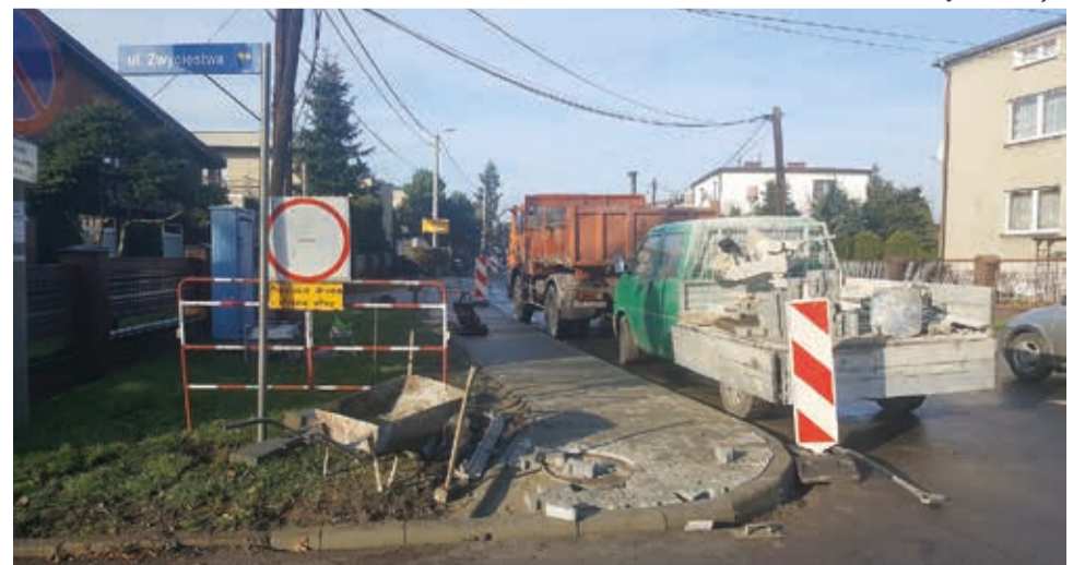
Remont chodnika przy ul. Głównej w Wyrach
